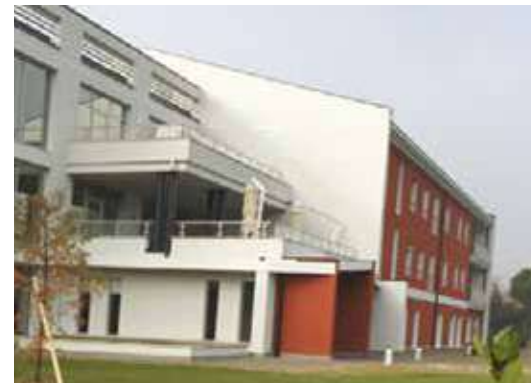
Casa Di Riposo Di Marghera Marghera - Venezia
